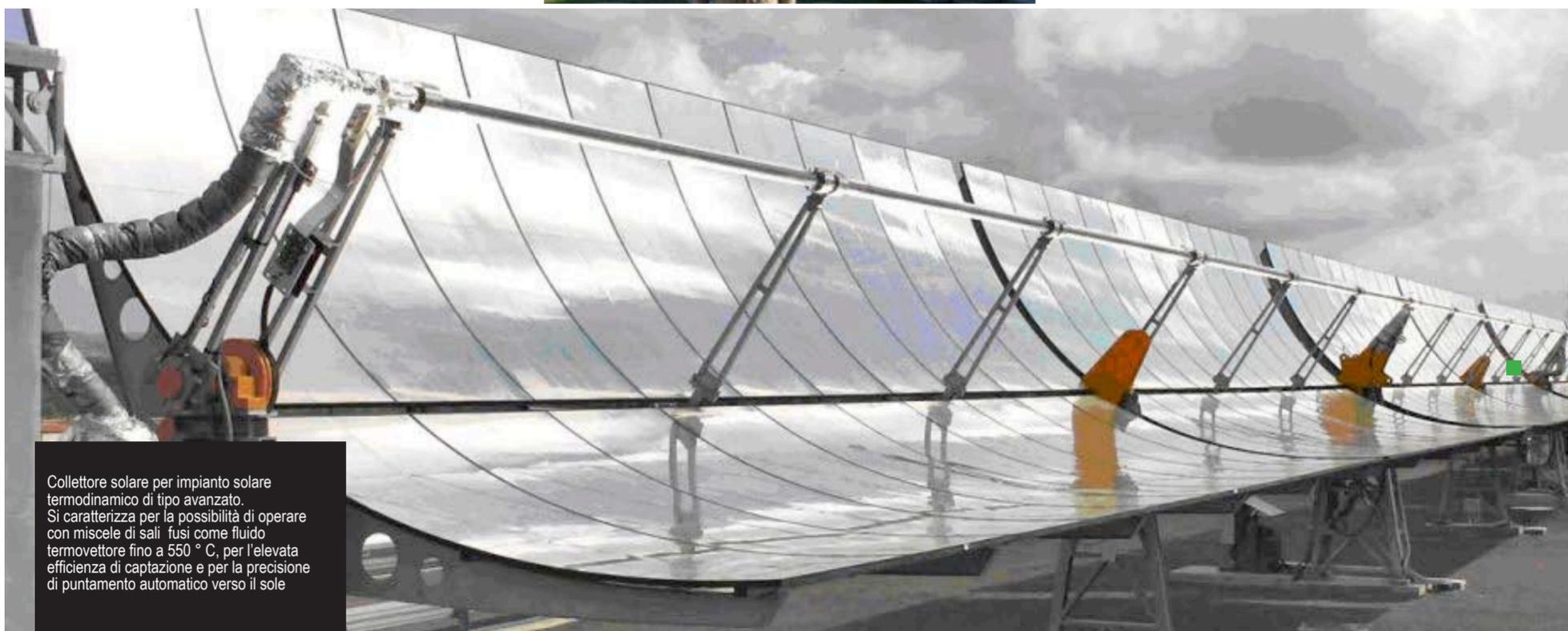
Collettore solare per impianto solare termodinamico di tipo avanzato. Si caratterizza per la possibilità di operare con miscele di sali fusi come fluido termovettore fino a 550 °C, per l'elevata efficienza di captazione e per la precisione di puntamento automatico verso il sole
